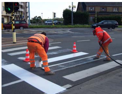
Foto 6.2 en Foto 6.3 Onderhoud voetgangersoversteekvoorzieningen
