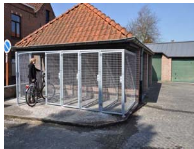
Figuur 18: Fietskluis in Brugge
