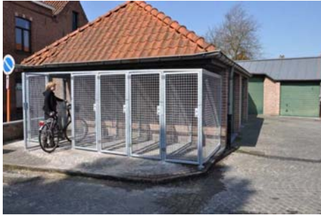
Figuur 19: Fietskluis in Brugge
